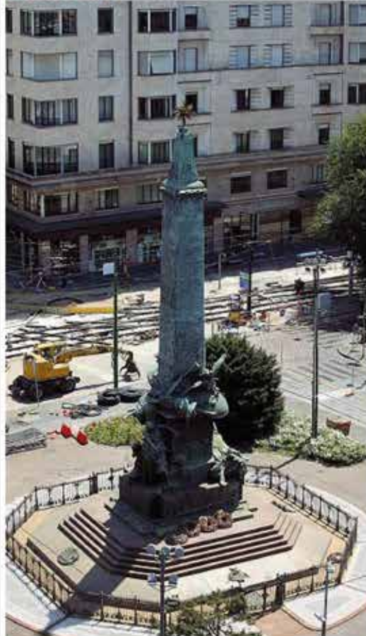
Percorsi Sui marciapiedi da ieri le indicazioni per «accompagnare» i pedoni attorno al cantiere
